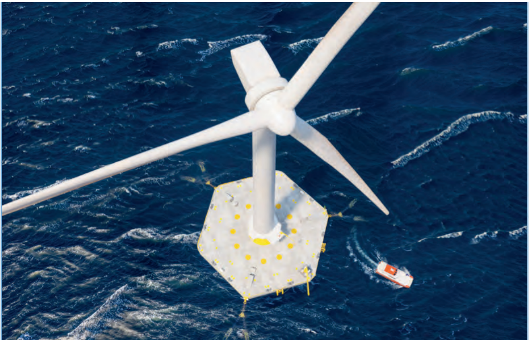
Figura 5. Imagen en planta de la tecnología TRIWIND. Beridi (2024).
