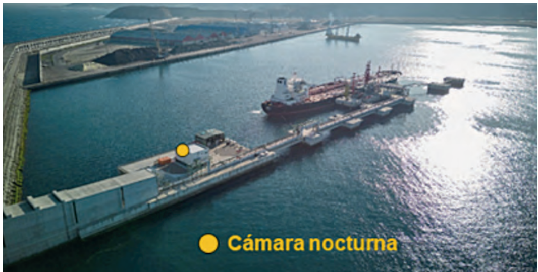
Fig. 1. Primera escala en el pantalán de Repsol del Puerto Exterior de A Coruña. Localización de la cámara nocturna de monitorización del rebase
