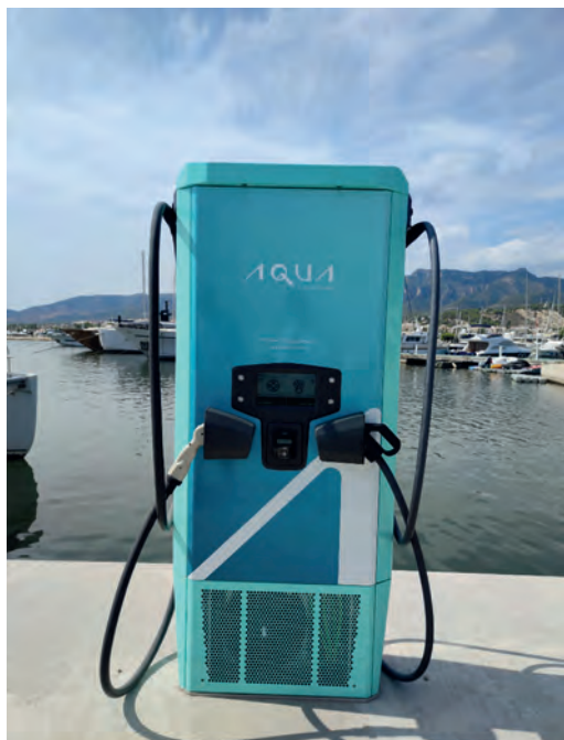
Fig. 2. Cargador eléctrico de embarcaciones y torreta inteligente. Fuente: Sener.
