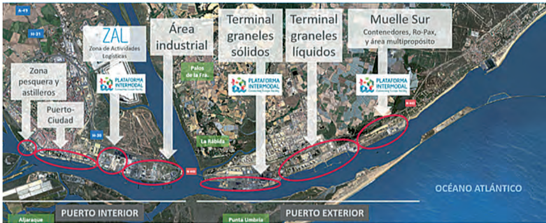
Fig. 1. Zona de servicio del Puerto de Huelva. Fuente: Autoridad Portuaria de Huelva (2023).
