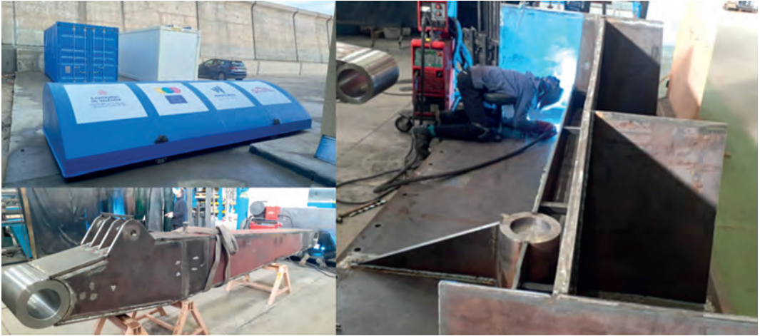
Fig. 9. Proceso constructivo del dispositivo convertidor. Fuente: Rotary Wave, 2022.
