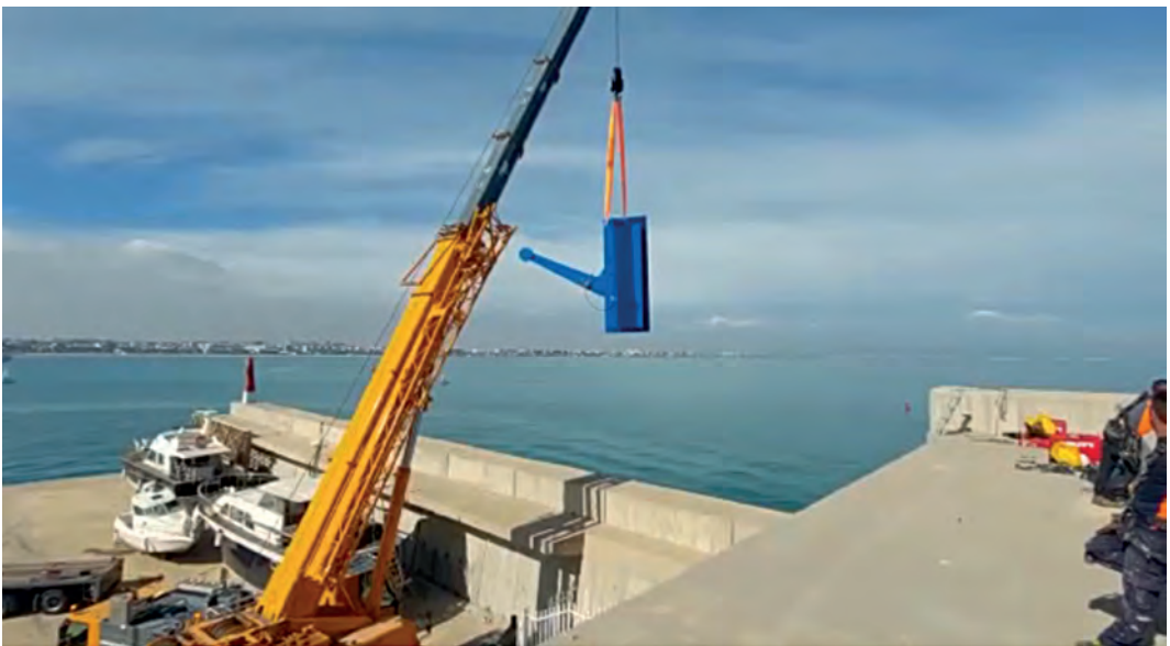
Fig. 10. Instalación del dispositivo convertidor. Fuente: Rotary Wave, 2023.
