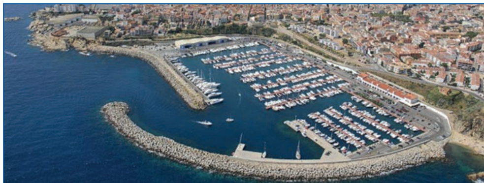
Fig. 6. Fotografía aérea de Marina Palamós. Fuente: Nàutic Palamós.
