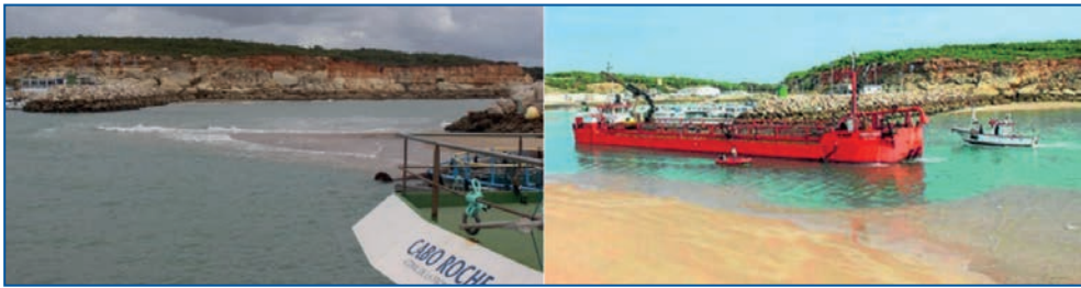
Fig. 10. Situación de la bocana y trabajos de dragado. Internet 2022.
