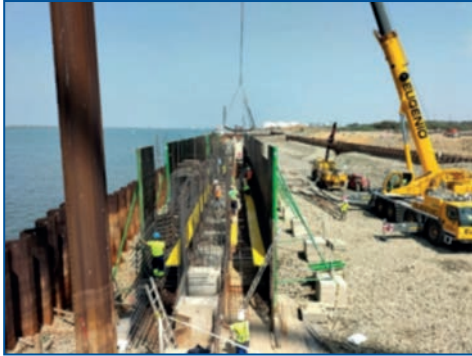
Fig. 15. Encofrado viga cantil.
