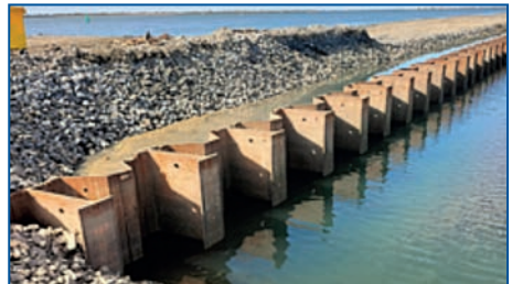
Fig. 7. Detalle del perfil de la tablestaca principal de la sección 1.
