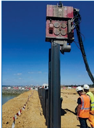
Fig. 10. Hincado pantalla de anclaje trasera.
