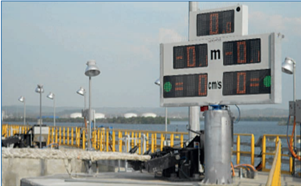
Fig. 2. Panel de mensajes variables sobre muelle. Fuente: Prosertek (2020).
