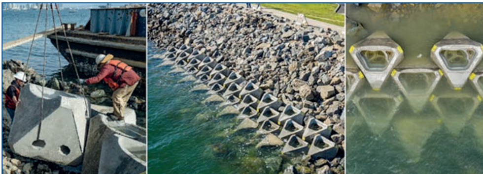
Fig. 3. Instalación de CoastaLock en el Puerto de San Diego, California, USA.
