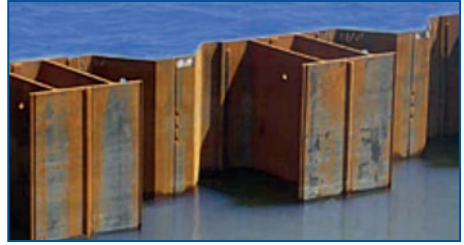
Fig. 5. Detalle del perfil de la tablestaca principal de la sección 1.
