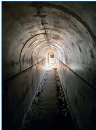
Fig. 17. Galería de la viga cantil.
