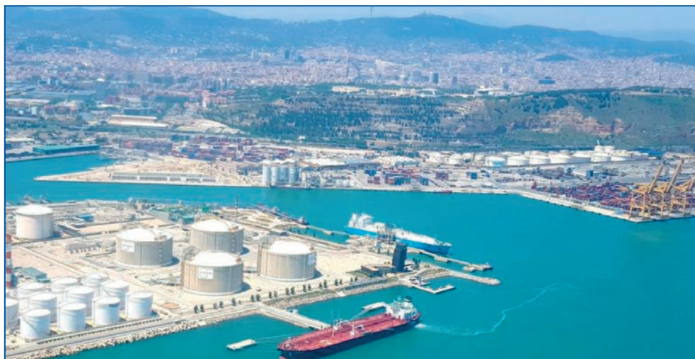
Fig. 1. Terminal de Enagás en Barcelona (fuente Siport21).
