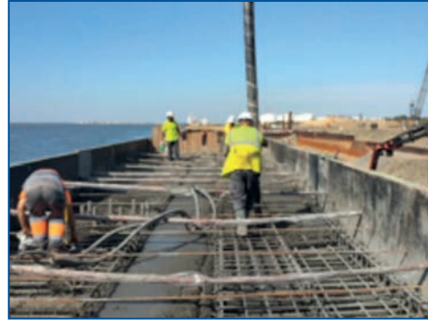
Fig. 16. Hormigonado viga cantil.
