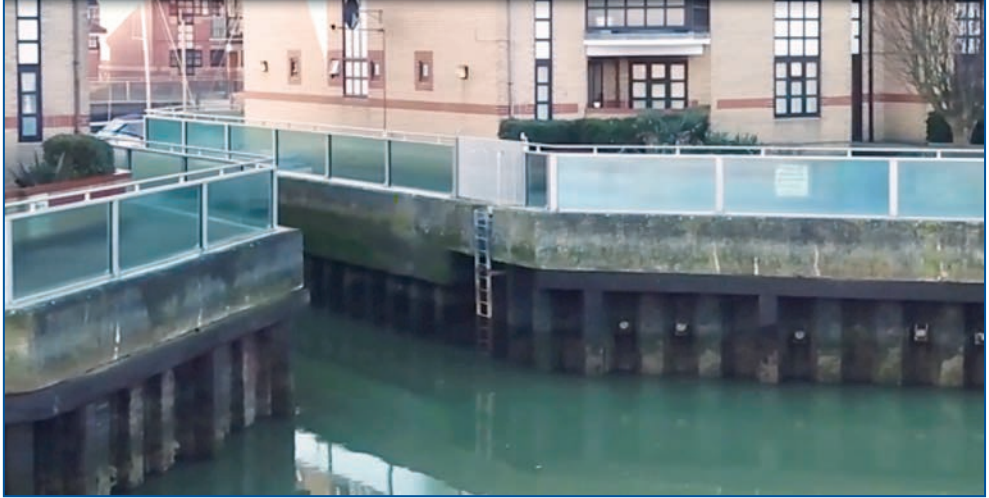
Fig. 6. Cristalera estanca sobre tablestacas antiguas. Fuente: Mackley (2020).
