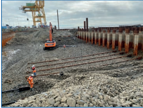
Fig. 12. Colocación de tirantes.
