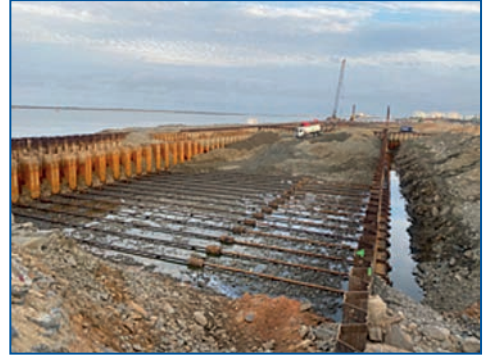
Fig. 13. Tirantes colocados.
