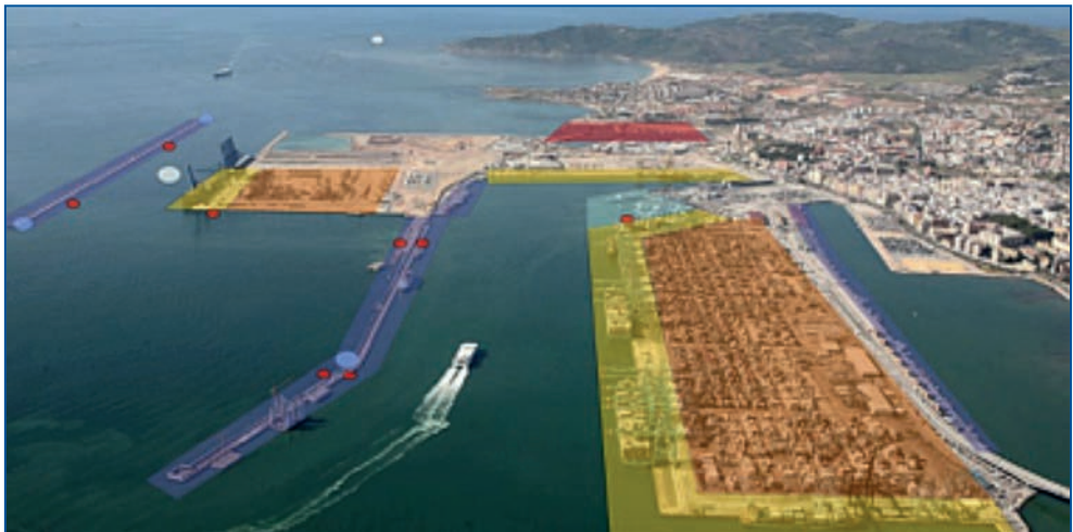
Fig. 2. AOI en el Puerto de Algeciras. Fuente: Propia (2017).
