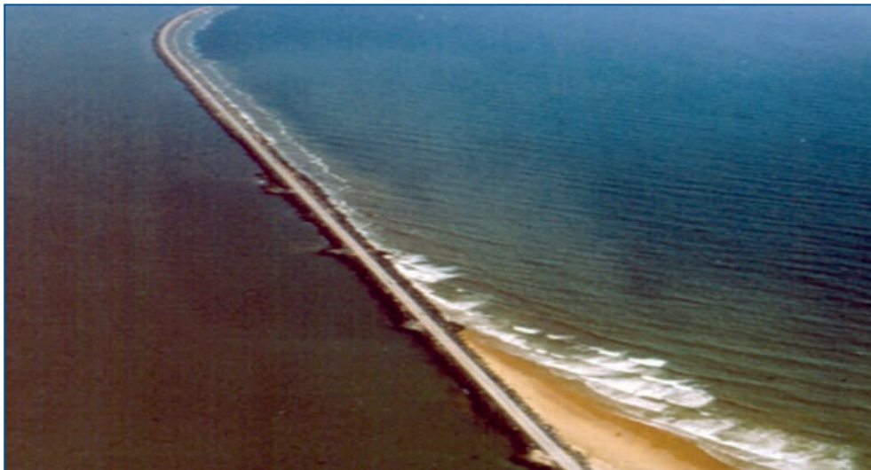
Fig. 6. Acumulación de arena en el dique del Puerto de Huelva. Fernández et al (1992).
