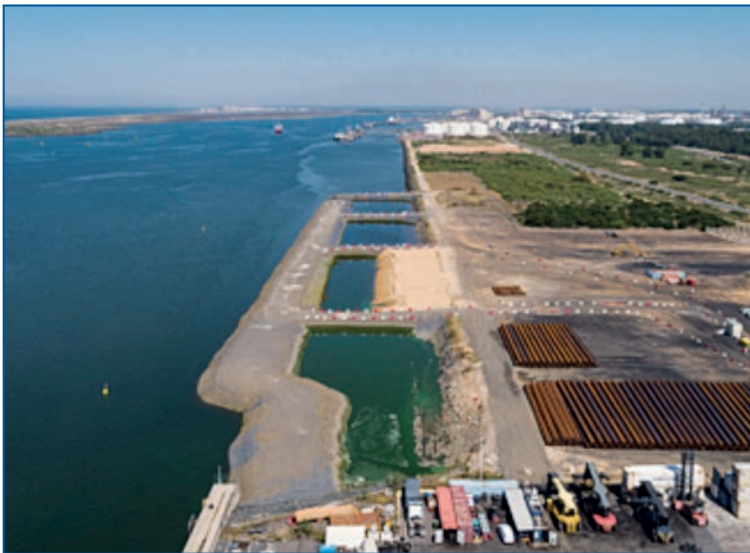
Fig. 3. Vista de las motas provisionales ejecutadas.
