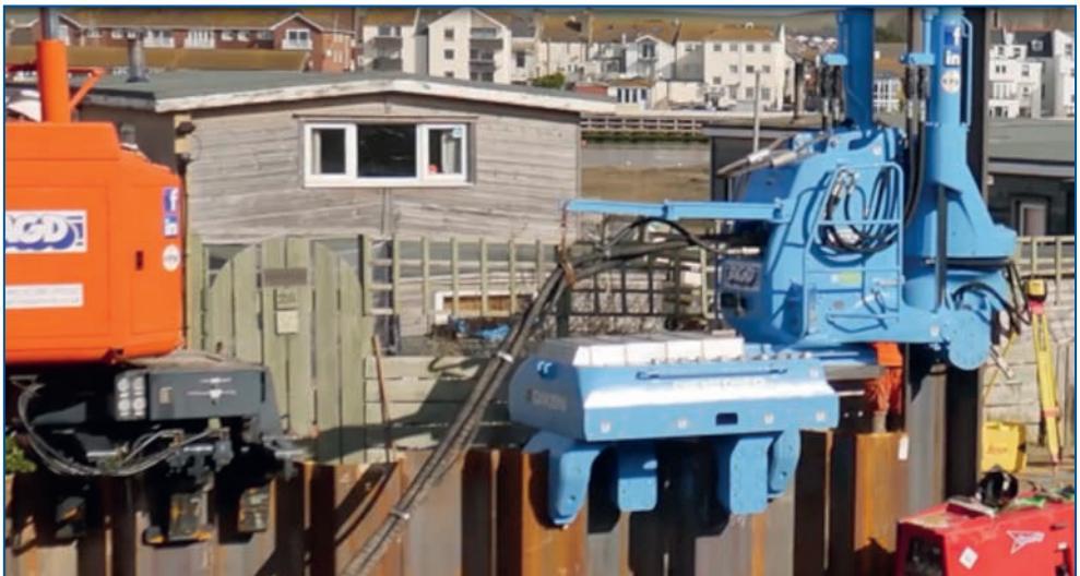
Fig. 7. Prensa Hydraulica Giken. Fuente: Mackley (2020).
