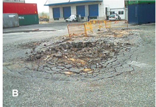
Ejemplos de daños que podrían calificarse como Ruinosos (R): A. Viga de un pantalán. B. Pavimento de un puerto.
