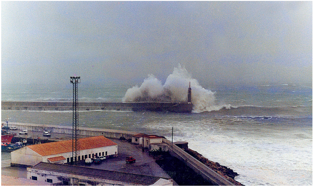
Figura 7. Fotografía temporal "Dique Sagrado Corazón", Puerto de Tarifa.
