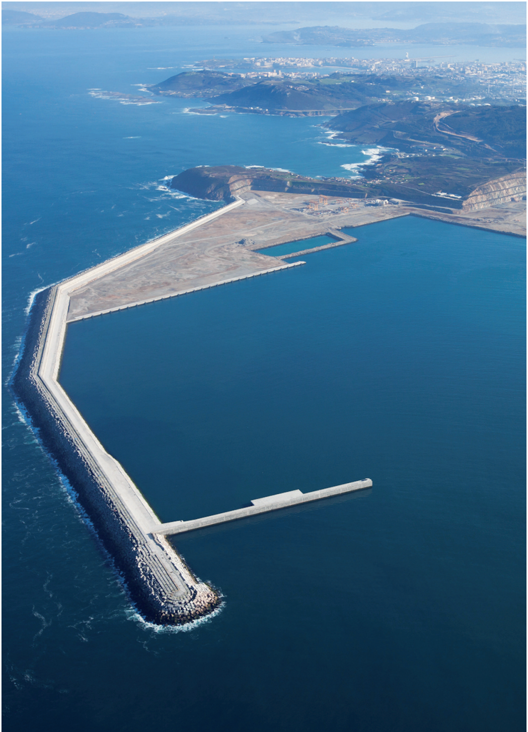
Dique del puerto exterior de Langosteira. Puerto de A Coruña.
