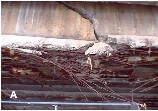
Ejemplos de daños que podrían calificarse como Ruinosos (R): A. Viga de un pantalán. B. Pavimento de un puerto.
