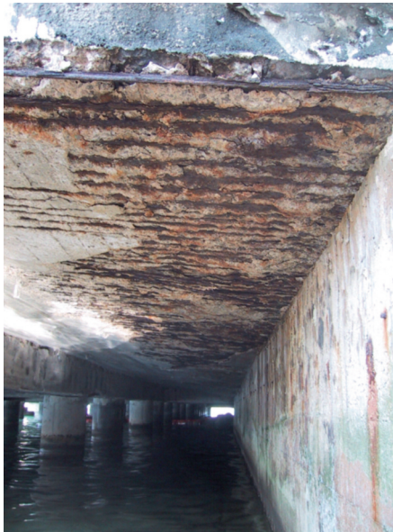
Ejemplos de daños por corrosión en cara inferior de un pantalán cuya trascendencia estructural lo califica como fuera de uso (calificación: 3).
