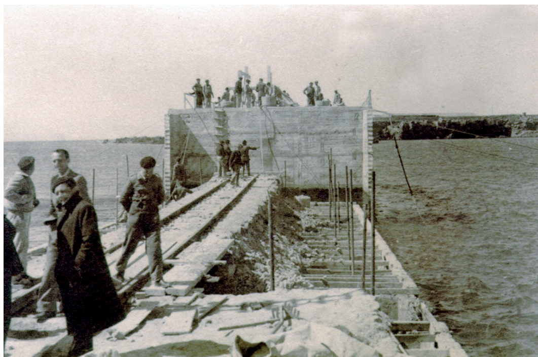
Figuras 20 y 21. Fondeo de cajón en prolongación de dique.
