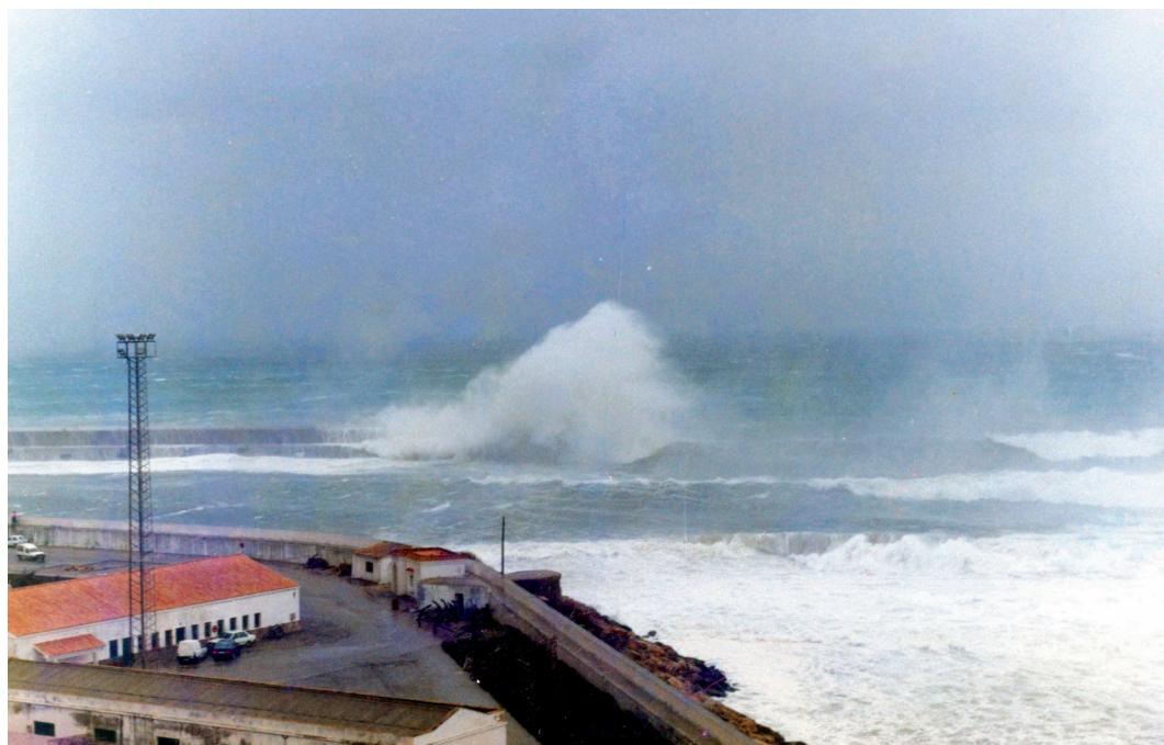
Figura 6. Fotografía temporal "Dique Sagrado Corazón," Puerto de Tarifa.
