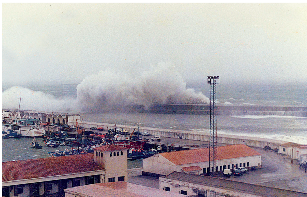
Figura 5. Fotografía temporal "Dique Sagrado Corazón," Puerto de Tarifa.
