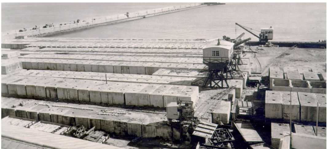
Figura 15. Fabricación de bloques y colocación con grúa "Titán" en avance de dique vertical.
