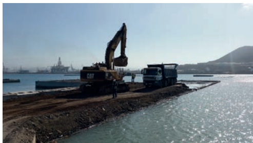
Figura 12: Relleno de celdas.
