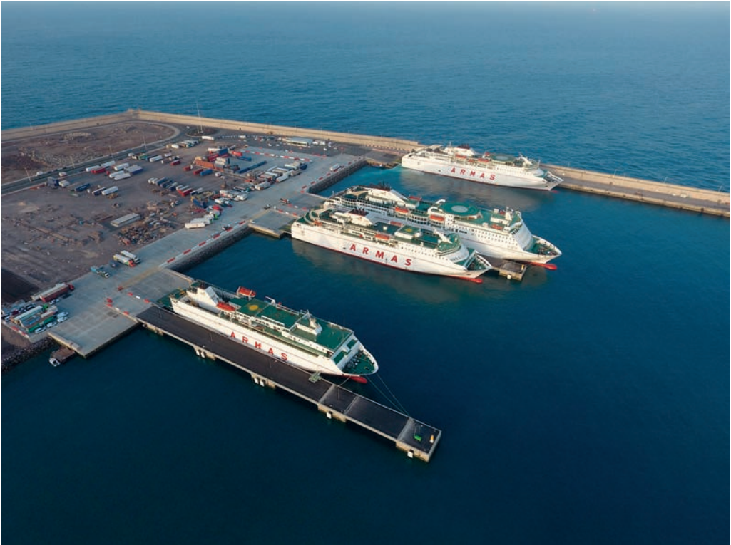
Figura 15: Estado final de las obras.
