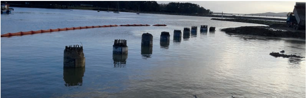
Figura 5: Pilotes ejecutados a la espera de deslizar las láminas.
