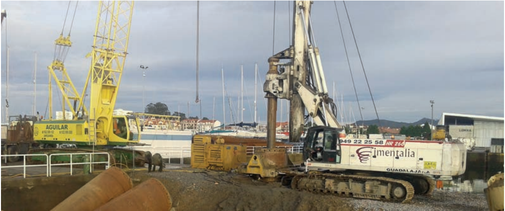
Figura 11: Maquinaria empleada para la ejecución de los pilotes.
