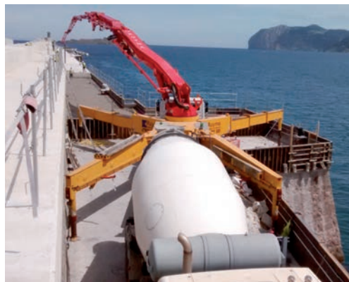
Empleo de bombas de hormigonado aprovechando al máximo la anchura del dique.
