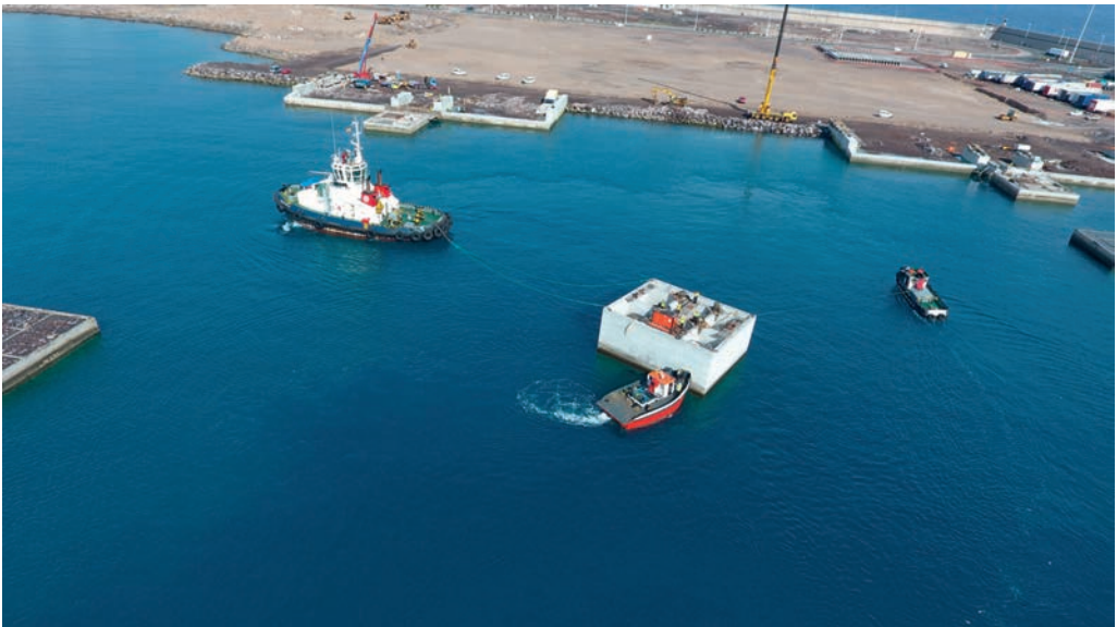
Figura 10: Remolque y fondeo de cajones en duques de alba.
