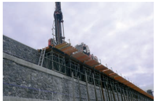
Uso de cimbra para el apoyo de la micropilotadora debido la escasa anchura del espaldón.
