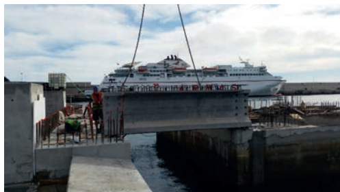
Figura 13: Colocación de vigas en puentes.
