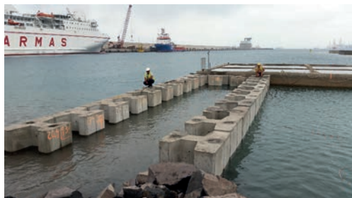
Figura 11: Cierres laterales en rampas.
