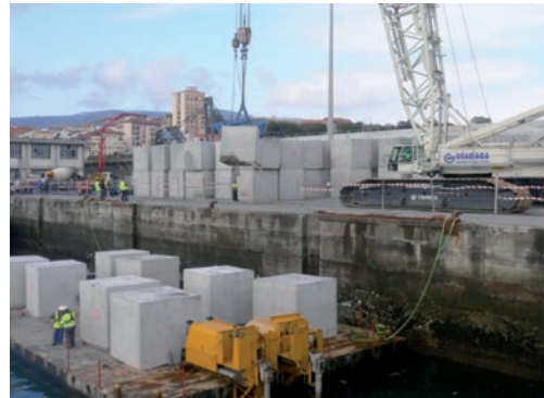
Transporte marítimo sobre pontona.
