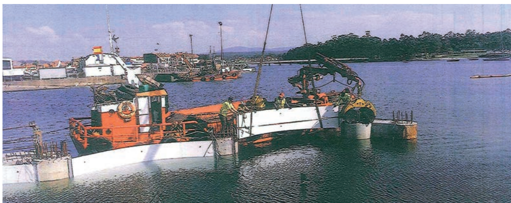
Figura 6: Deslizado de las láminas entre pilotes.
