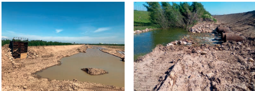
Figura 1: Caja de agua y vertido del vaciadero Copero II.
