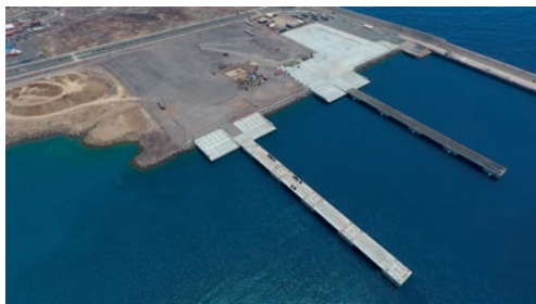
Figura 14: Ejecución de losas y pavimento.
