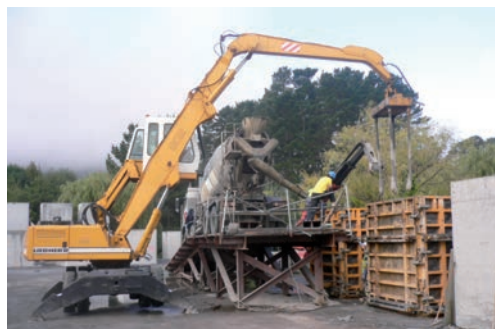
Vibrado del hormigón con retro y vibradores de aguja debido a su dureza.
