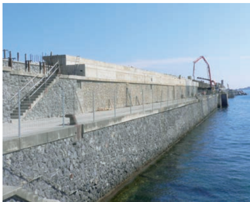
Avance en las labores de recrecido del espaldón.
