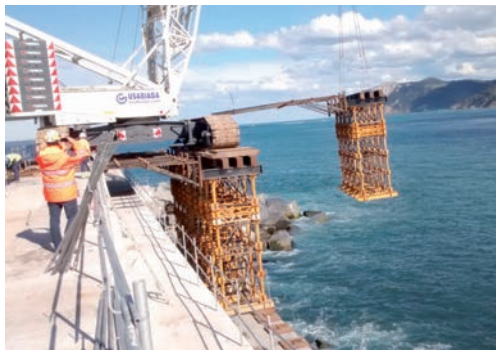
Movimiento de los módulos de la cimbra para el avance de la grúa por el dique.
