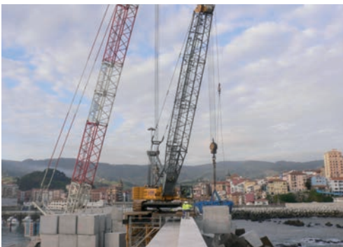
Grúa de 180 t colocando bloques de 40 t.
