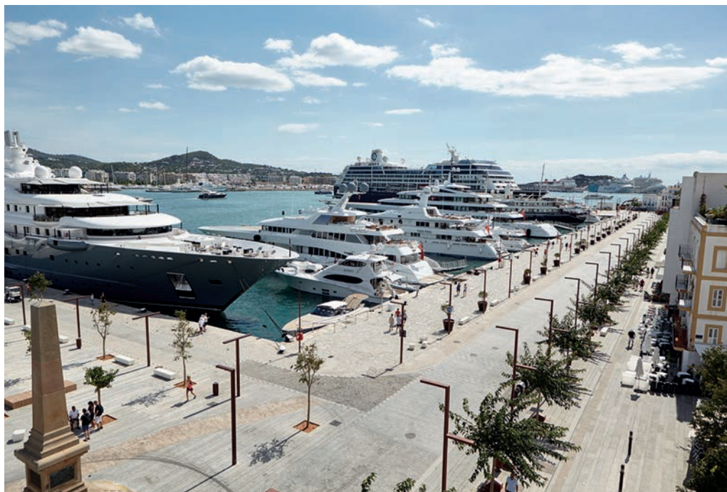
Figura 4: Vista del nuevo paseo portuario y la nueva dársena de Poniente para embarcaciones náutico-deportivas de gran eslora.
