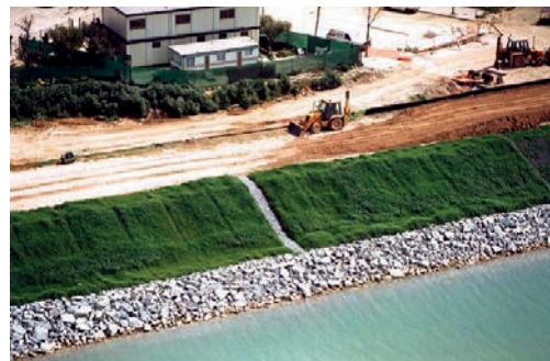
Figura 8: Manta biodegradable y geocompuestos en el delta del Llobregat, zona baja del río.
