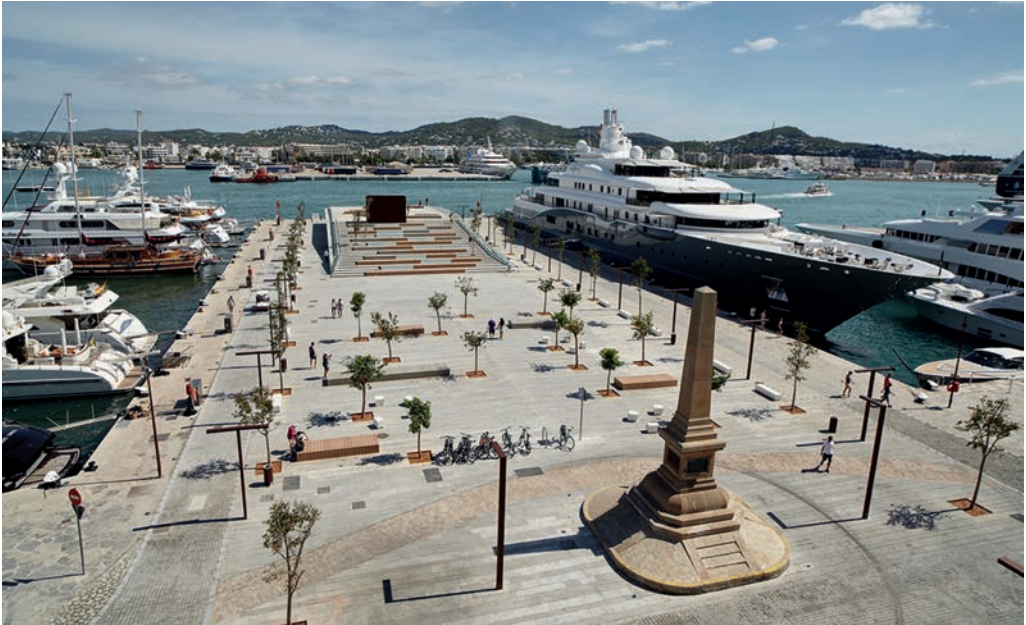
Figura 5: Imagen del Contramuelle donde se observa la plaza pública y el edificio-mirador con su escalinata-graderío.
