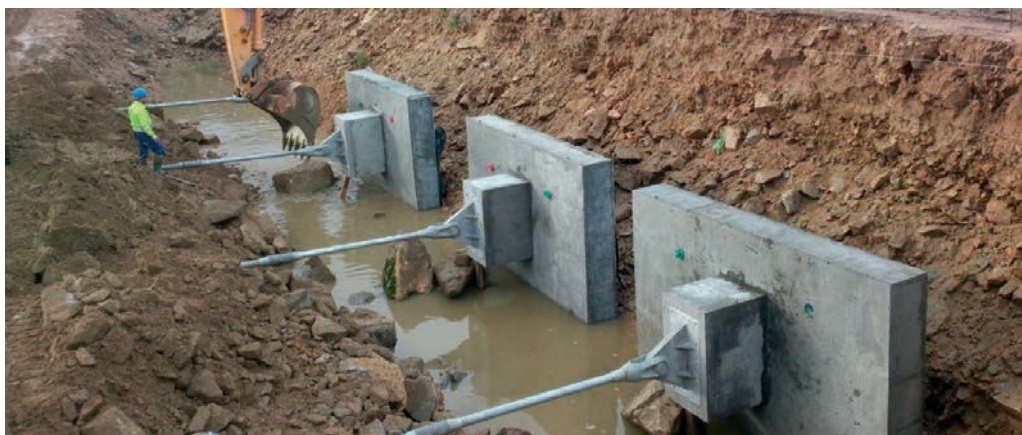
Figura 7: Muros de reacción y barras de anclaje.
