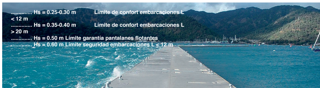
Figura 4: Vista efecto atenuador barrera antioleaje flotante.
