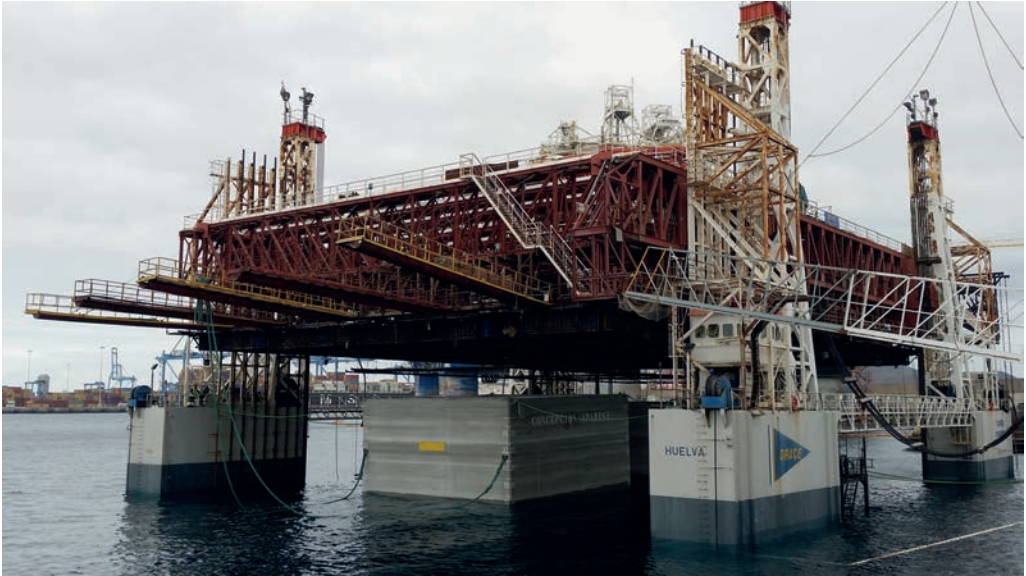
Figura 9: Fabricación de cajones.
