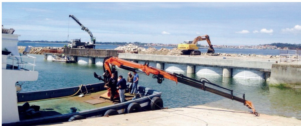
Figura 10: Viga de coronación.
