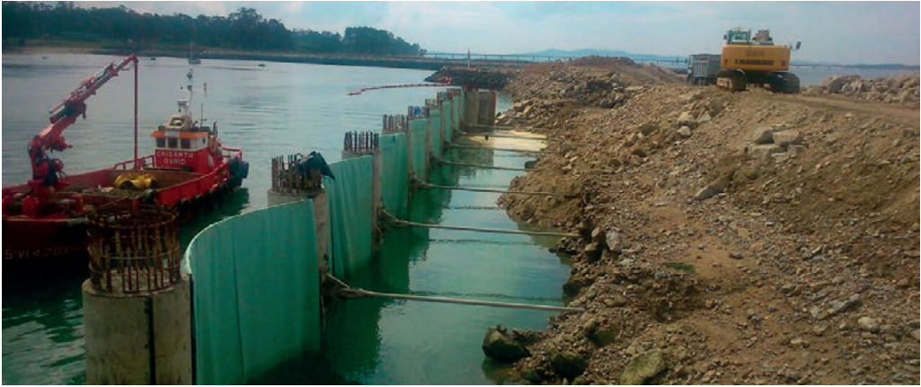
Figura 8: Barras de anclaje y ejecución del relleno de trasdós del muelle.
