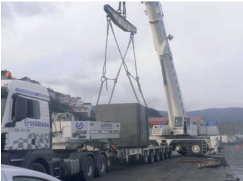
Transporte terrestre en camión góndola.
