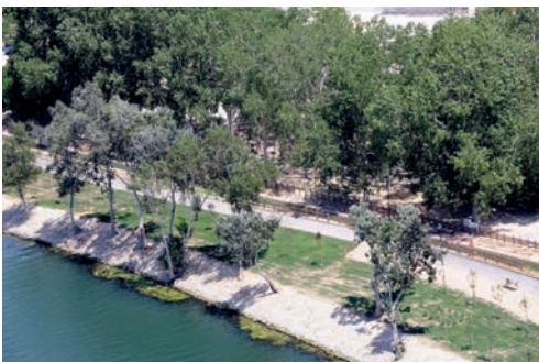
Figura 7: Manta de bloque de hormigón en el Delta de L’Ebre, en la márgenes del río.
