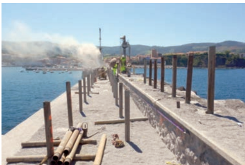
Avance en las labores de micropilotaje.
