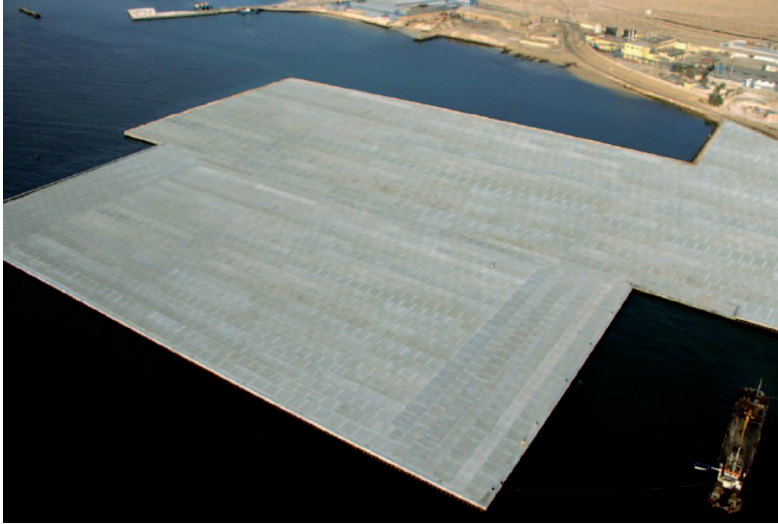
Imagen 3: final de las obras.
