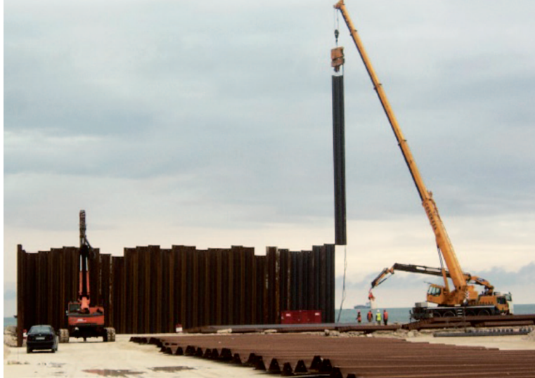
Imagen 1: Hinca de tablestacas.
