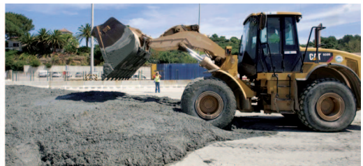
Fig. 8. Operaciones de extendido y secado de los lodos.
