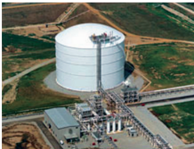
Tanque intermedio de GNL.
