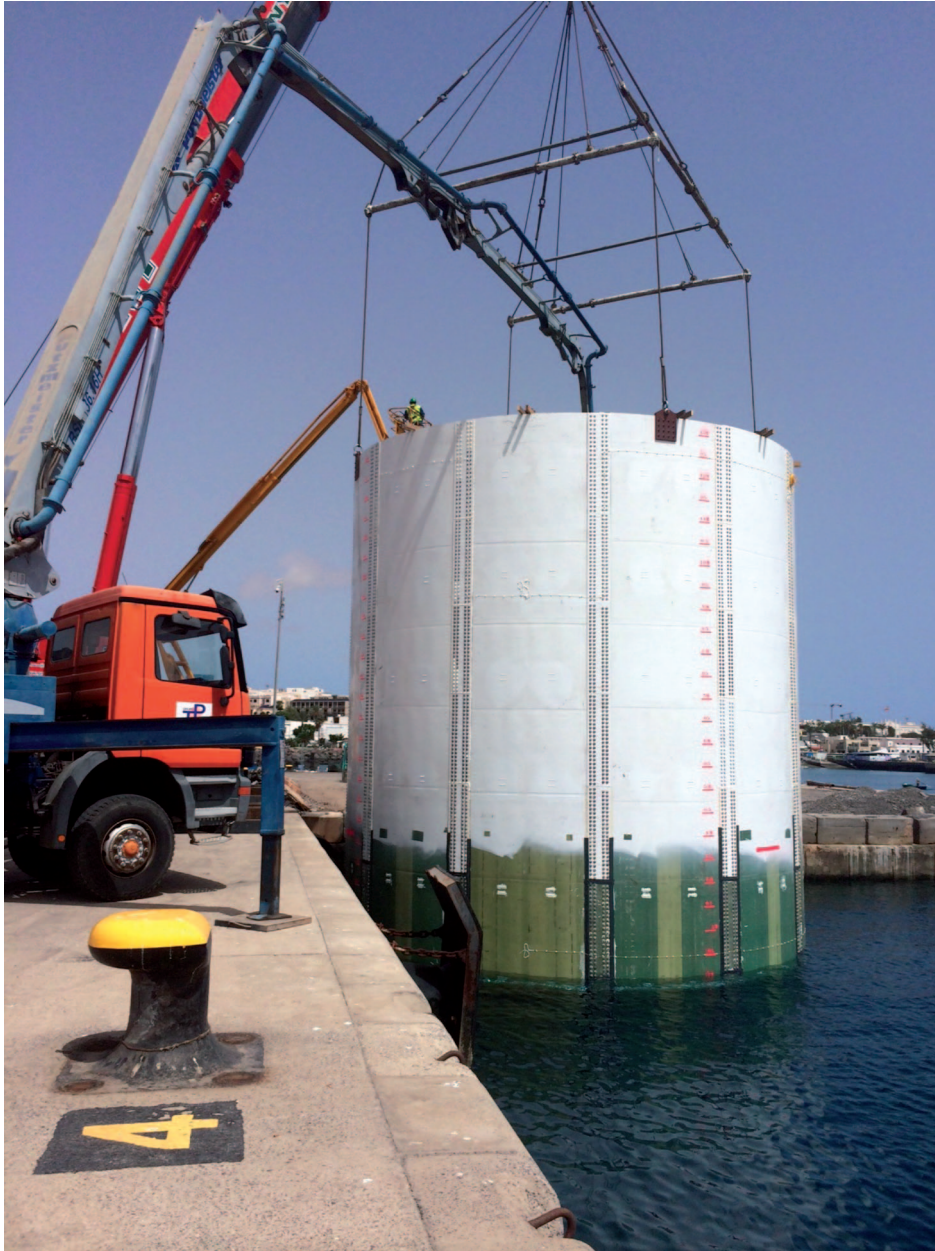
Hormigonado Losa interior de fondo.
