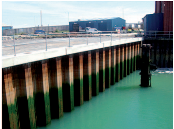
Imágenes de muelles ejecutados con tablestacas, en fase de construcción (izquierda), y ya finalizado (derecha).
