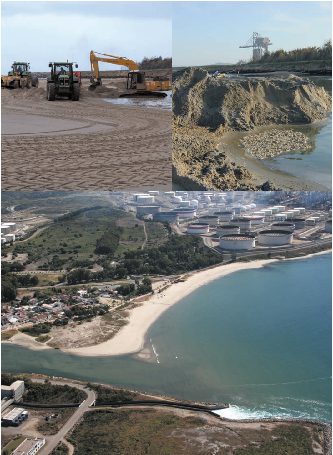
Figura 36. Trabajos dragado río Guadarranque y trasvases longitudinales de arena (2005).
