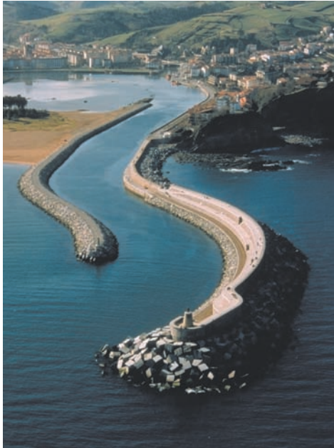
Figura 18. Ampliación del Dique de encauzamiento del Urola, Zumaya.
