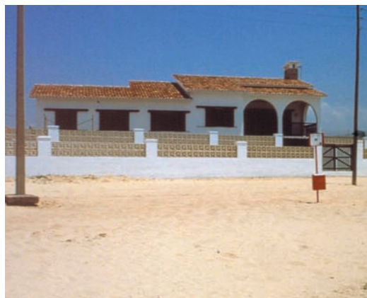
Figura 13. Doble valla (¿?), presumiblemente para ir “avanzando” en dominio público portuario, antes de su desafectación a d.p.m.t, gestionado por la Demarcación de Costas.
