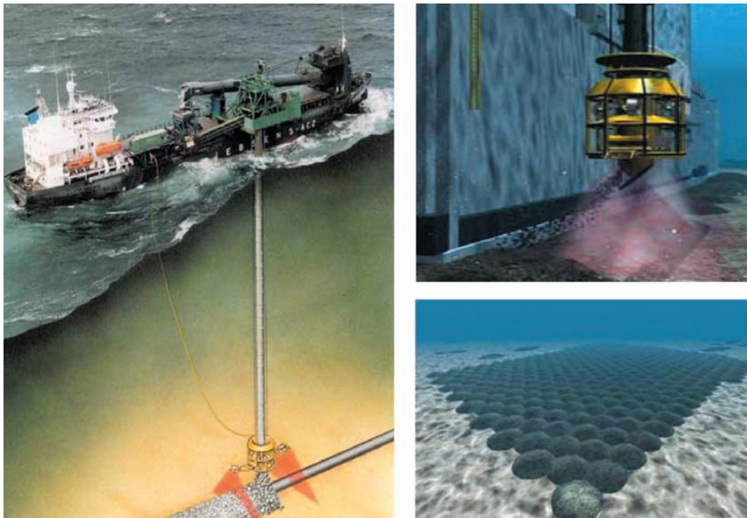
Figura 26. Oferta de Construcción. Equipo para enrase de grava.
