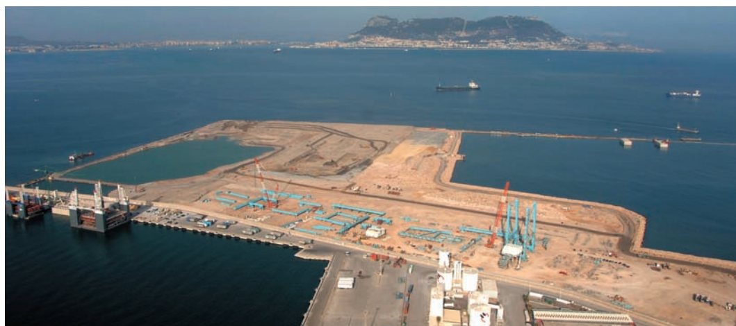
Figura 31. Avance de las obras. Septiembre de 2006.
