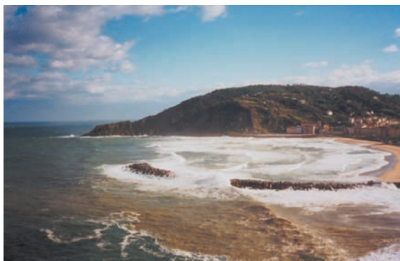
Figura 9. Espigón de playa de la Zurriola, San Sebastián, fuertemente rebasable.
