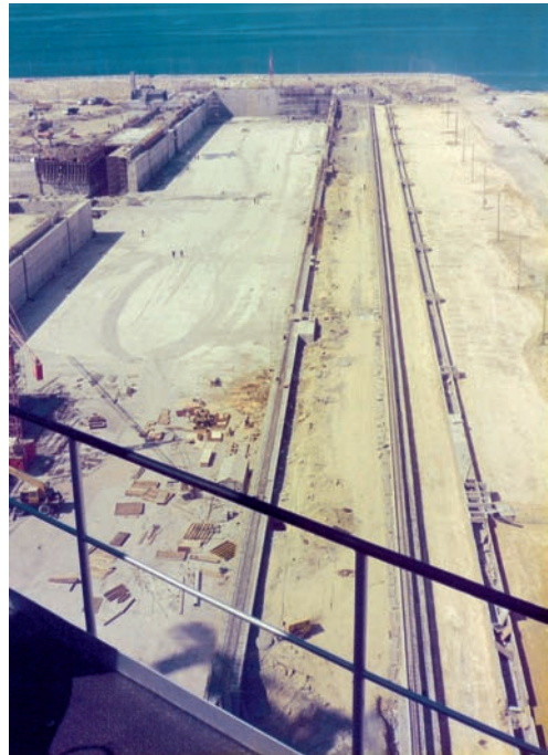
Figura 4. Ejecución del dique.
