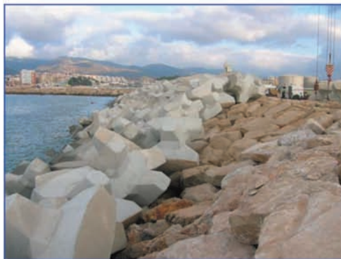
Figura 29. Detalles de la ejecución del dique.
