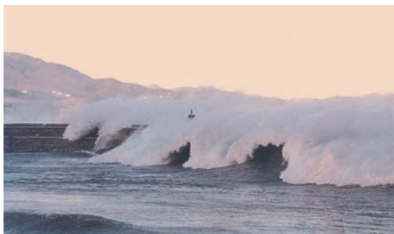
Figura 7. Efecto del oleaje sobre el Dique de Zumaya. Temoral de noviembre de 1996.
