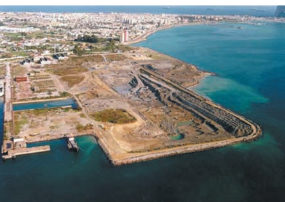
Figura 12. Excavación de la dársena.
