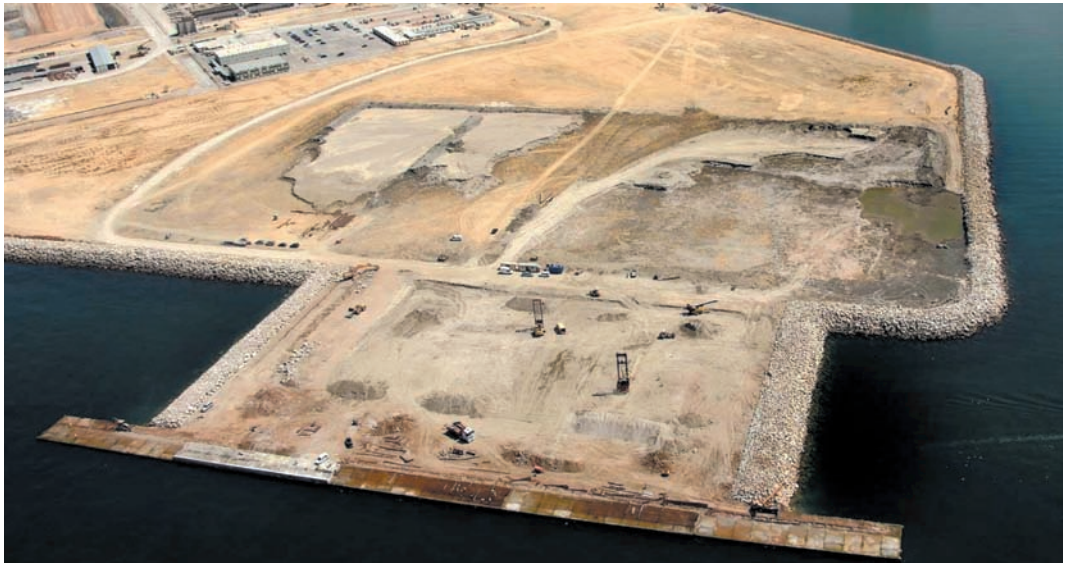
Figura 34. Ejecución del tratamiento de mejora.
