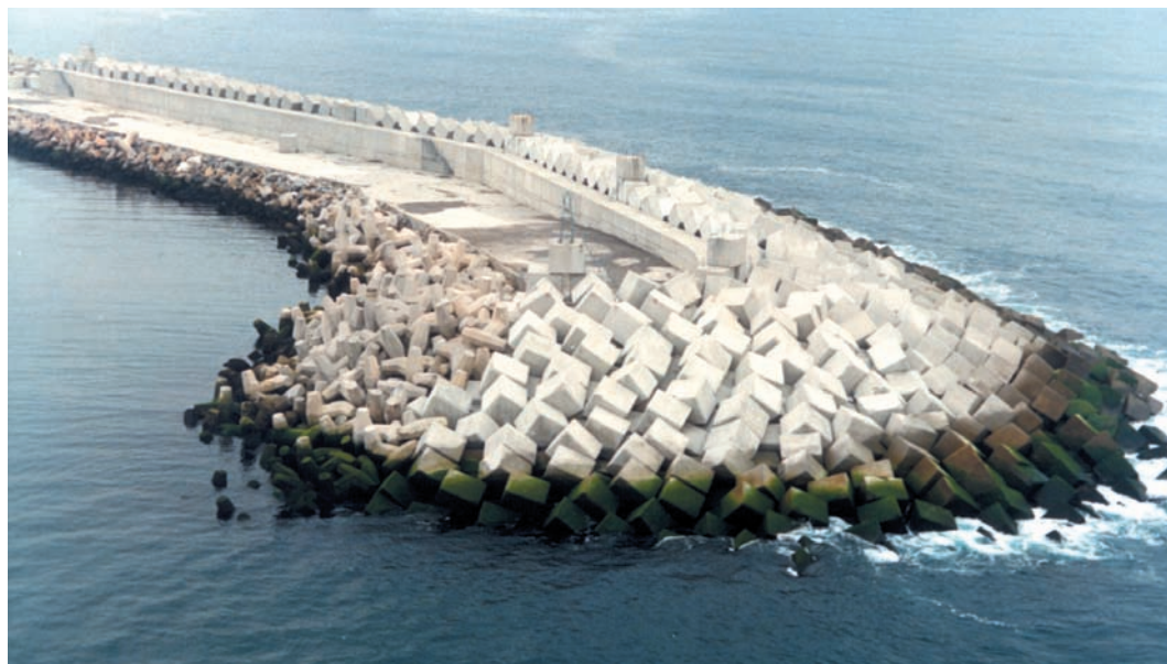
Figura 2. Dique rompeolas en talud con bloques de 90 tm orientados (3/1). San Ciprián, Lugo.
