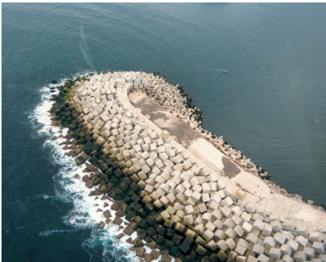
Figura 20. Estado final del morro reparado del dique norte de San Ciprián, Lugo.
