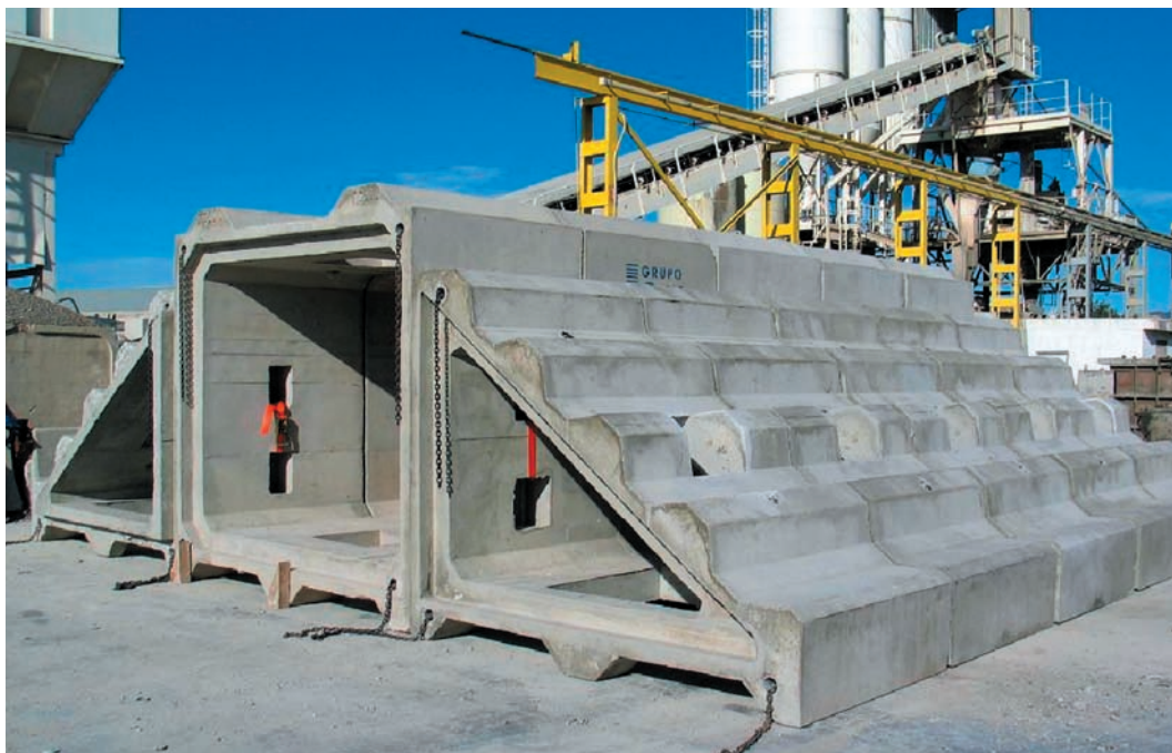
Figura 4. Dique modular TCT colocado en la Playa de Santa M a del Mar (Cádiz).
