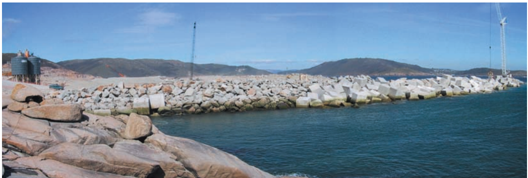
Figura 16. Vista general del dique en fase constructiva a sección completa, Ferrol (2002).
