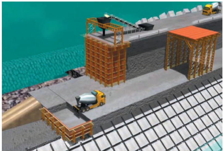
Figura 16. Oferta de Contrucción. Ejecución del Espaldón.
