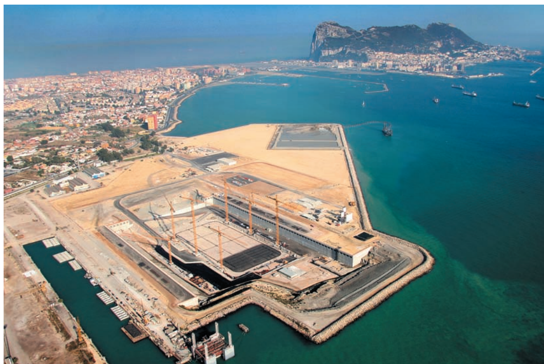
Figura 1. Instalaciones portuarias de Campamento. Agosto de 2005.
