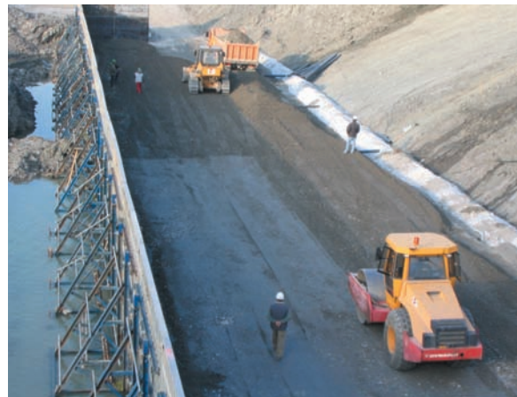
Figura 30. Ejecución de HCR.
