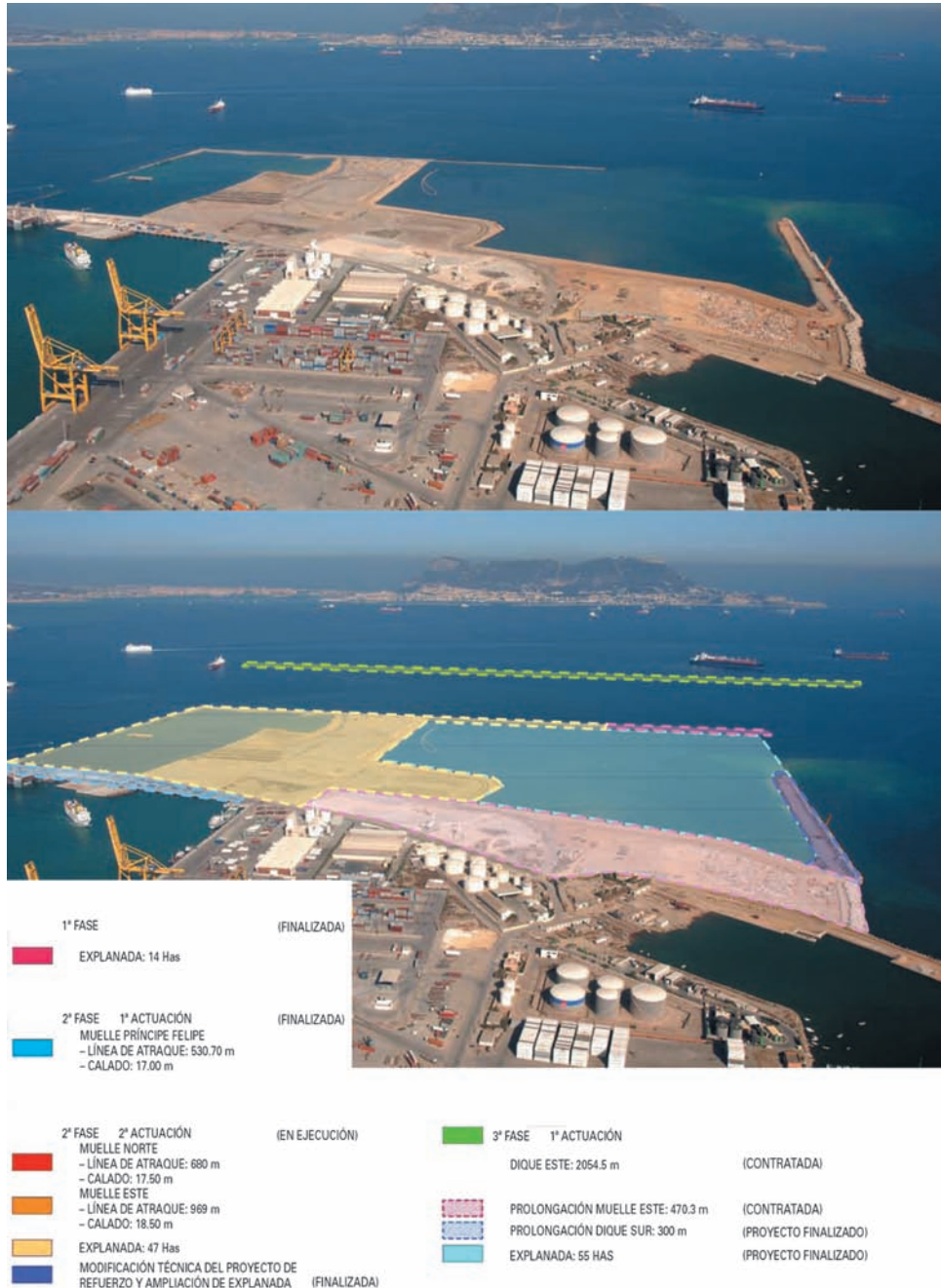
Figura 30. Avance de las obras. Septiembre de 2005.
