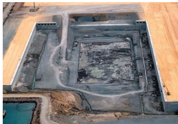
Figura 31. Vista de las obras.
