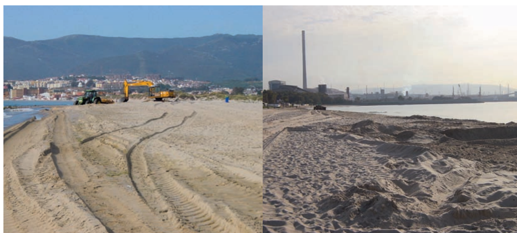
Figura 34. Trasvases longitudinales de arena desde el extremo sur (acumulación espigón) hasta la zona erosionada en el extremo norte. Playa de Palmones, T.M Los Barrios (2005).
