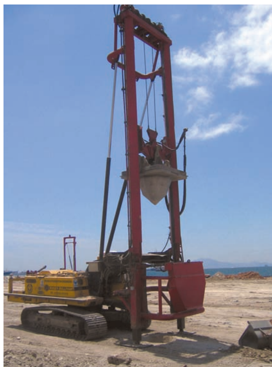
Figura 33. Detalle del equipo empleado en la compactación dinámica.
