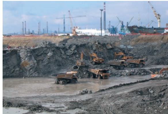
Figura 29. Frente de avance de la excavación tras la voladura.
