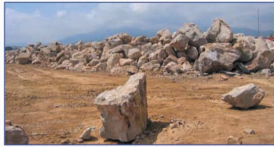
Acopios de escollera
