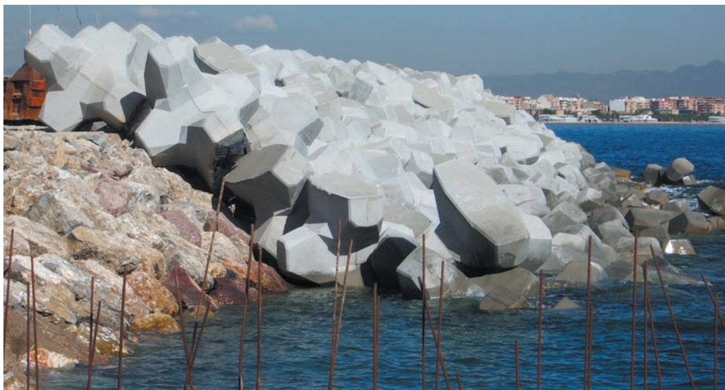
Figura 6. Fase constructiva de un dique rompeolas de piezas especiales en manto (Valencia, 2005).
