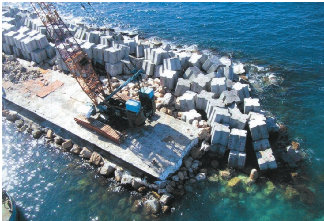
Figura 3. Construcción a sección completa del dique de Ashdoc, Israel.
