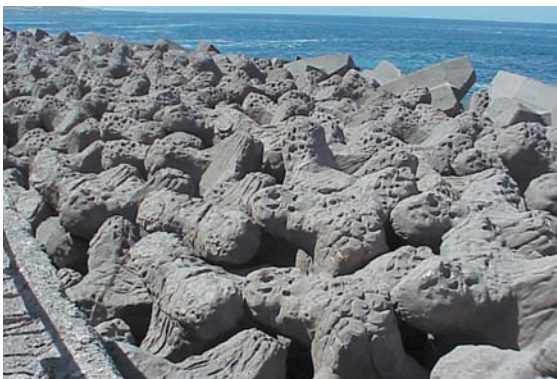
Figura 11. Vista de un manto con piezas ecológicas tipo "ecópodos".
