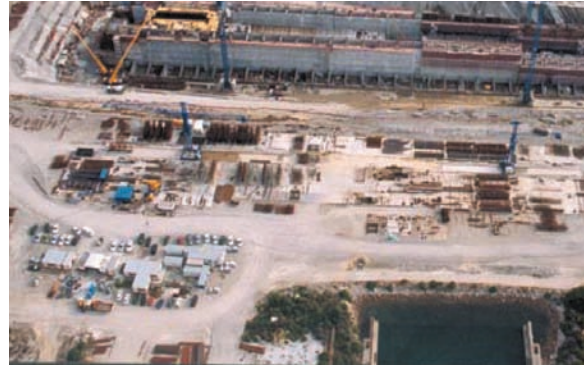
Figura 15. Parques de ferralla.
