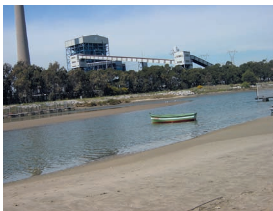
Figura 24. Espigón de encauzamiento margen derecha, bordeado por la Central Térmica.
