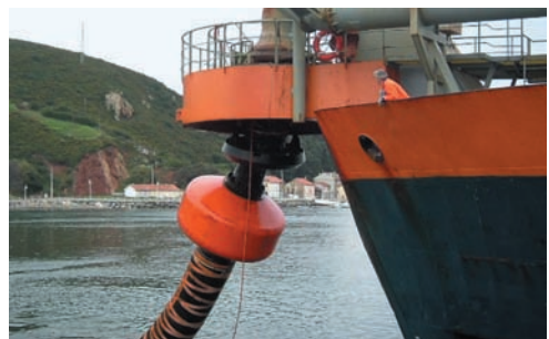
Figura 6. Conexión de la tubería para efectuar el vertido
