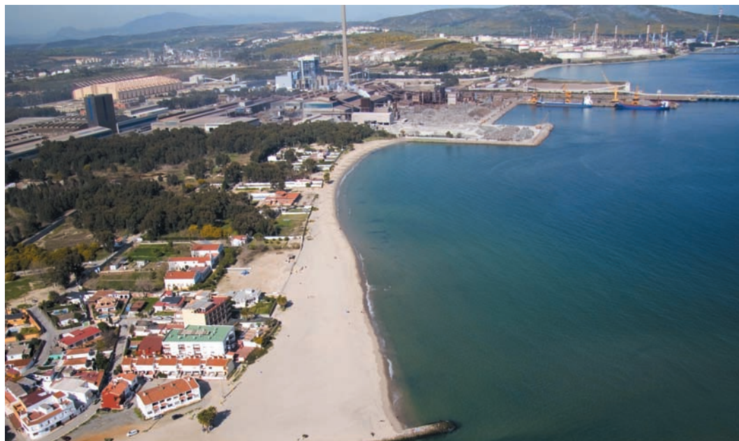
Figura 23. Basculamiento hacia el sur, antes del comienzo de las obras de emergencia 2005.
