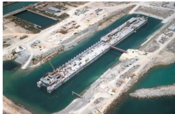
Figura 16. Puente de acceso.
