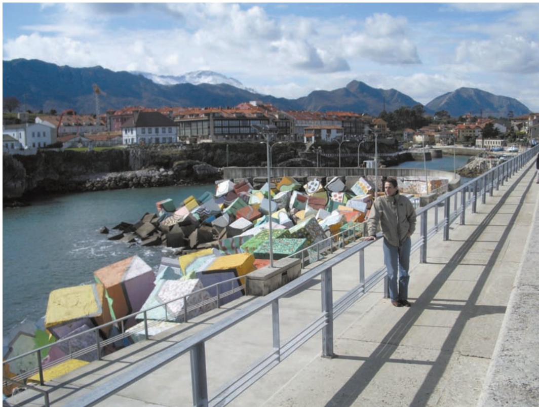
Figura 5. Ejemplo de integración paisajística del manto de un dique rompeolas (Llanes, 2006).
