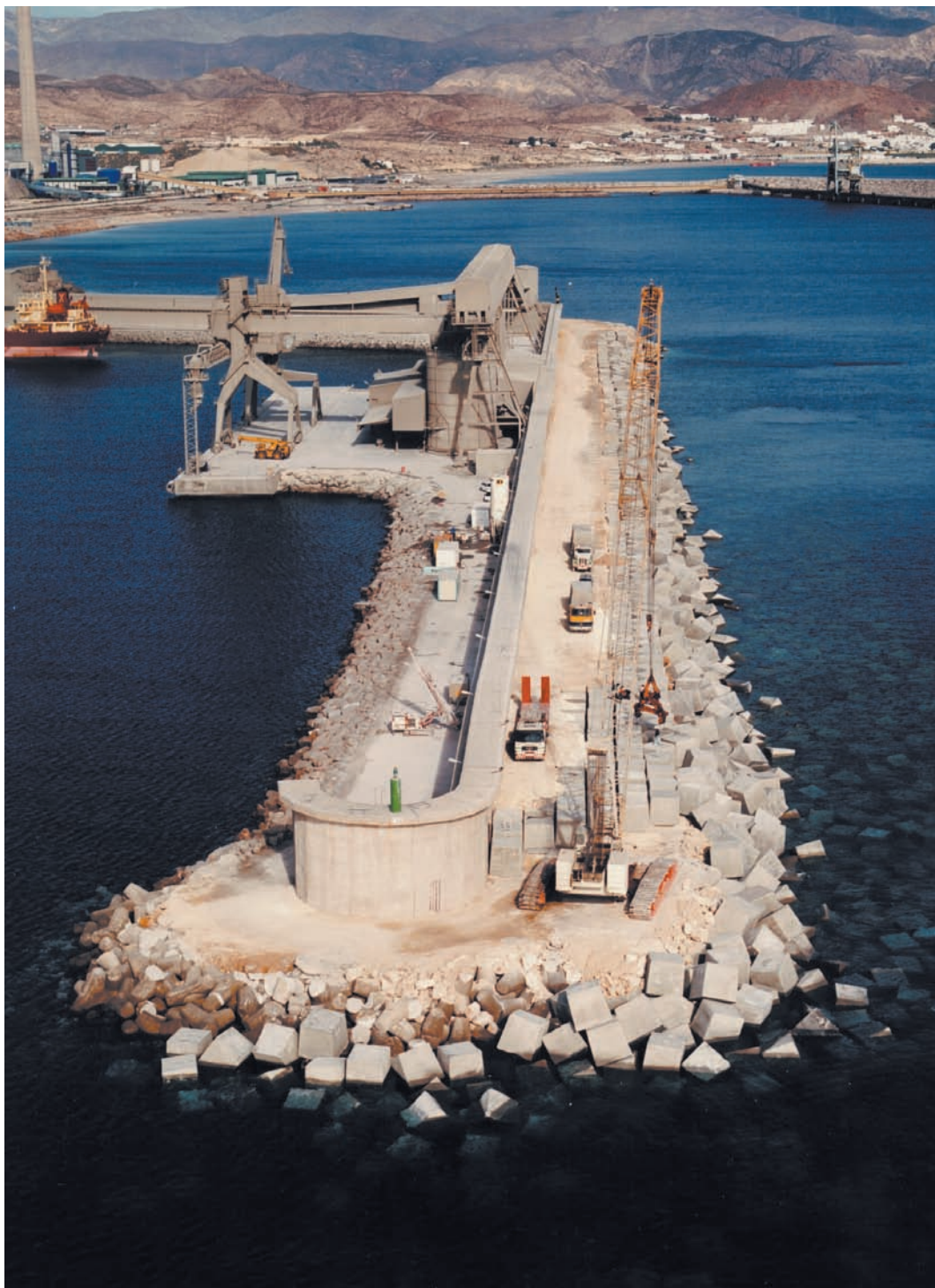
Figura 17. Reparación del Dique del Puerto de Hisalba, Carboneras, Almería con bloques de 30 t en manto y 5 t en pie.
