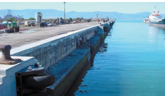
Figura 9. Adaptación de superestructura
