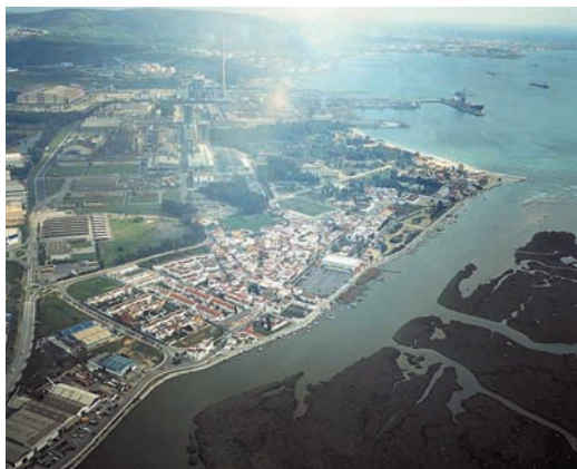
Figura 18. Urbanización margen izquierda, en ocasiones con vertidos incontrolados a la marisma.
