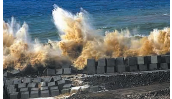
Figura 4. Temporal en fase de ejecución de un rompeolas.
