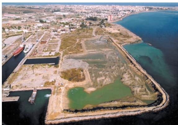
Figura 11. Cierre de la ataquía y achique.
