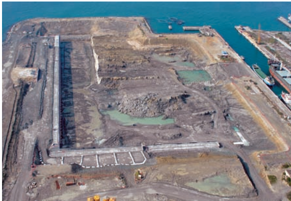
Figura 28. Vista de las obras.
